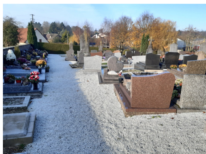
Travaux de réfection du cimetière
