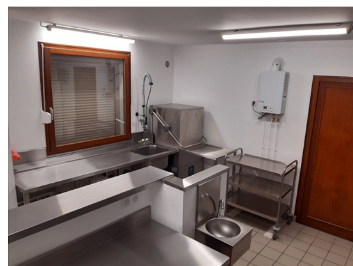
Travaux de réfection de la cuisine de la salle des fêtes
