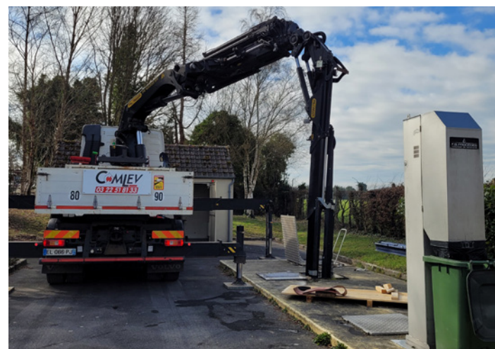
Le changement de la pompe de relevage des eaux usées par les services d'Amiens Métropole
