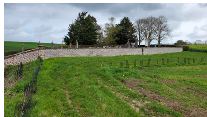
Rénovation du mur du cimetière
