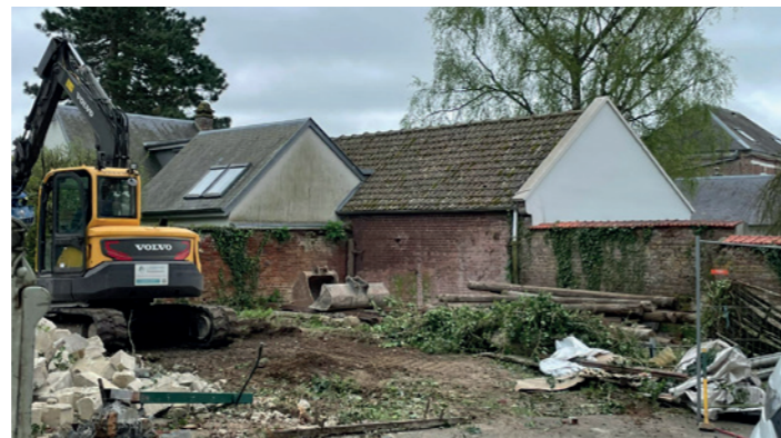
La démolition de l'ancien atelier communal
