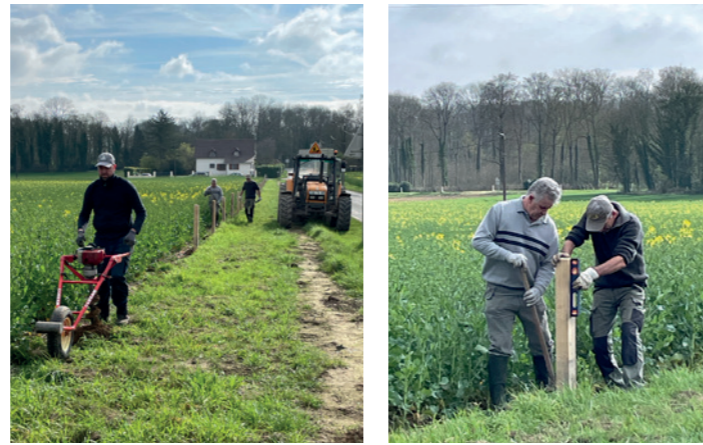
La mise en place de poteaux pour délimiter le chemin le long de la rue d'Anjou afin de se rendre au stade de façon sécurisée.
