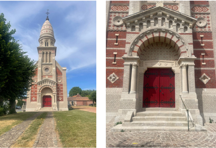
L'église, la fin des travaux
